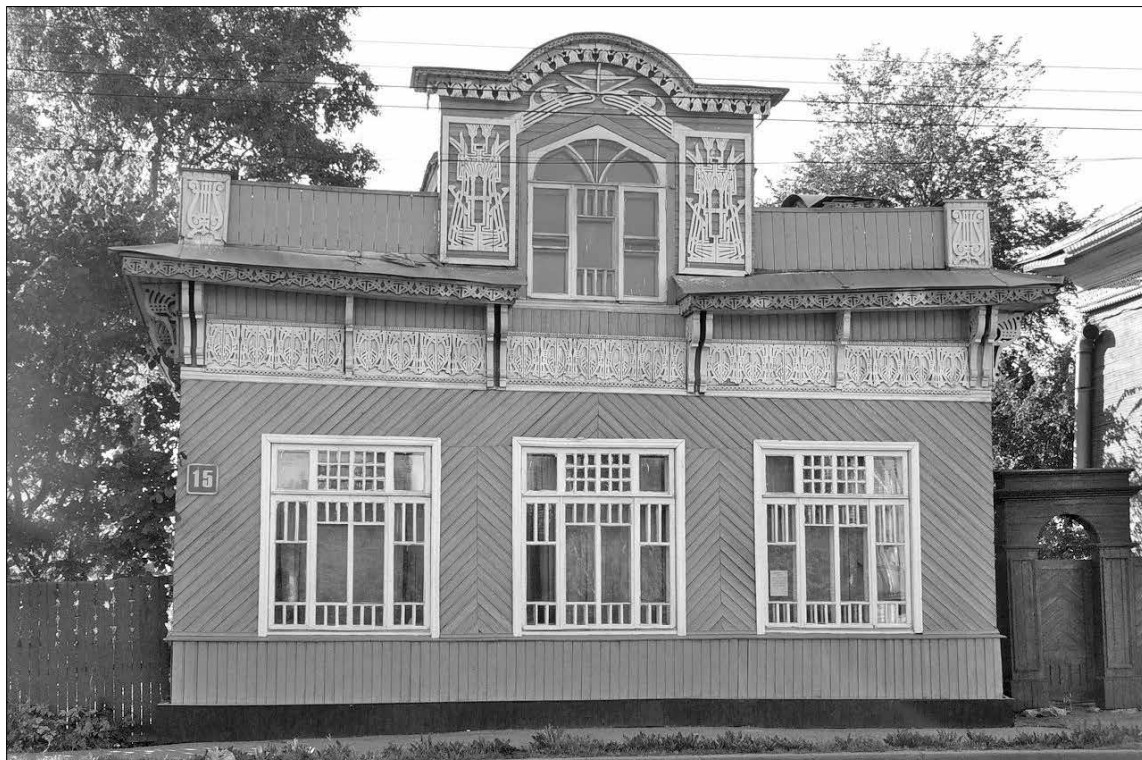
Дом Зернова на улице Чернышевского, 15.
