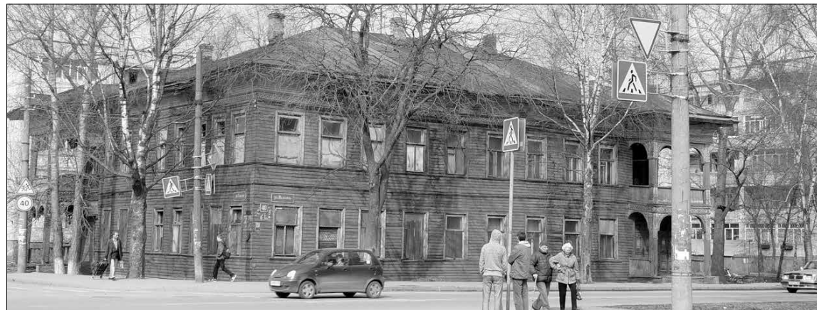
Дом купца Смирнова на ул. Кирова, 32/40.
